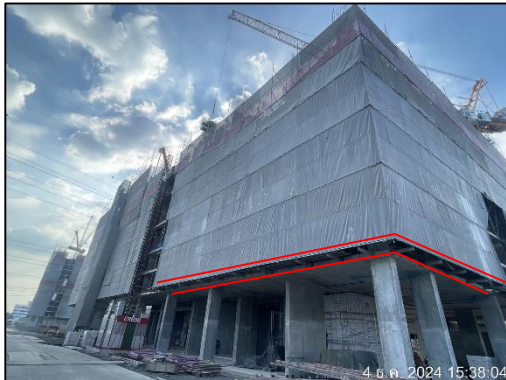
ภาพที่ 65 ตะแกรงป้องกันวัสดุตกลง
